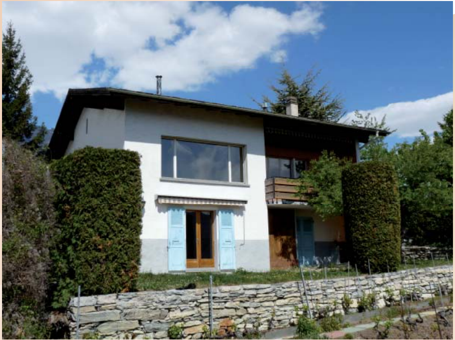
La maison de l'Impasse de la cure qui abritera la crèche et l'UAPE
